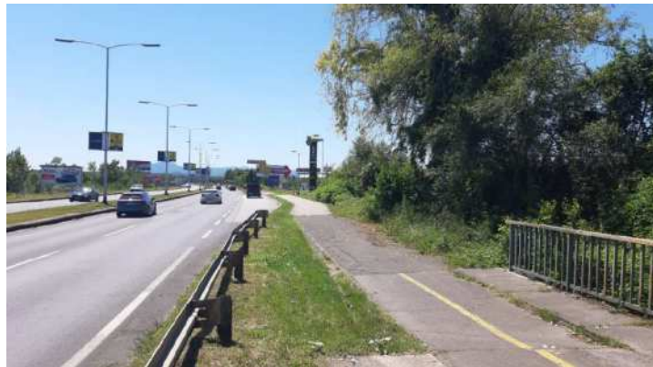
Postojeći odvojak sa Ljubljanske avenije (smjer zapad)
